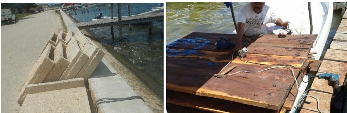
Figura 7. Izquierda) Sombras langostera de concreto en el puerto de Chiquilá; Derecha) Construcción de una sombra langostera de dos niveles de madera de chicozapote en el puerto de Chiquilá.
